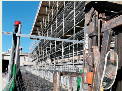
防護柵欄及工作廊道
