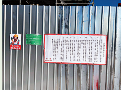
安全守則及工程名稱、廠商標示
