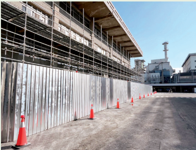
安全錐及夜間照明
